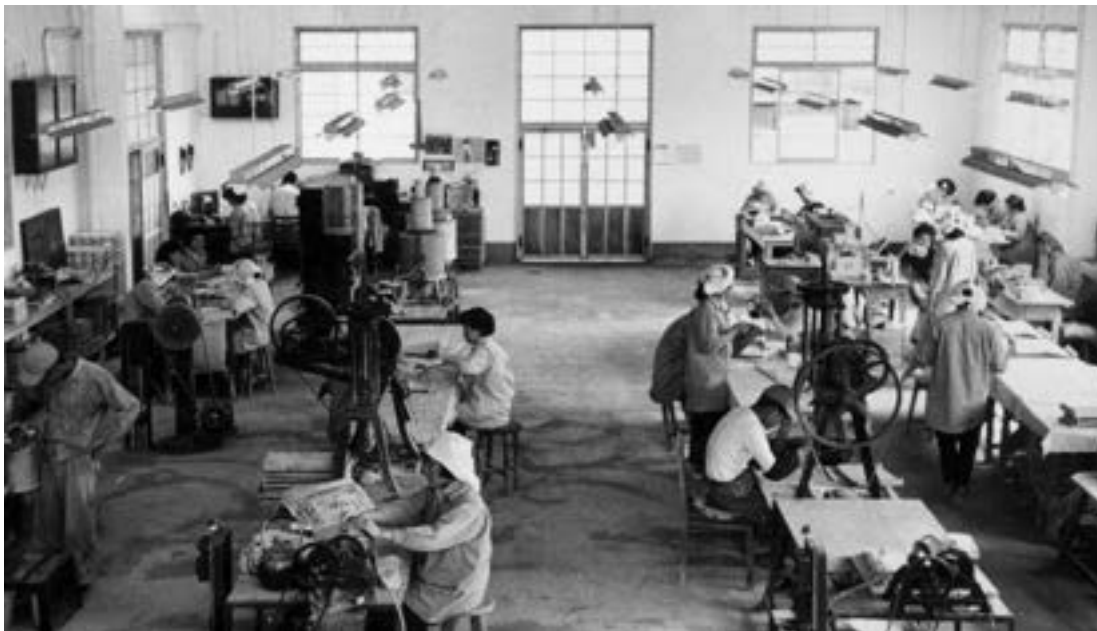
1957年頃の素地工場（高崎工場）
