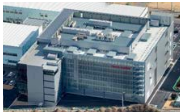
八幡原工場材料棟（群馬県高崎市）
