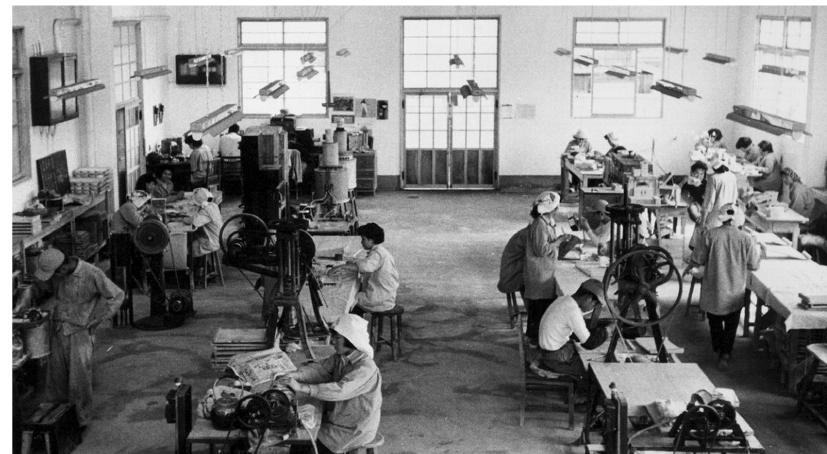
1957年頃の素地工場（高崎工場）
