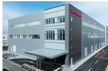
玉村工場5号棟(群馬県佐波郡玉村町)
