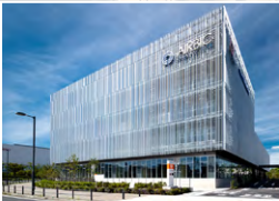
新川崎センターSOLairoLabが入居するAIRBIC
