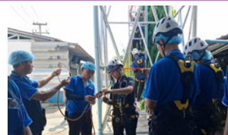
高所作業安全対策教育
